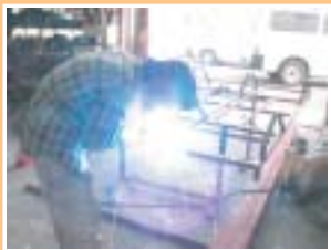
▲当社での製作の様子(浴槽作業) 完成後は見えませんが、スチール製フレームがボードやプレートなどを支えています。
